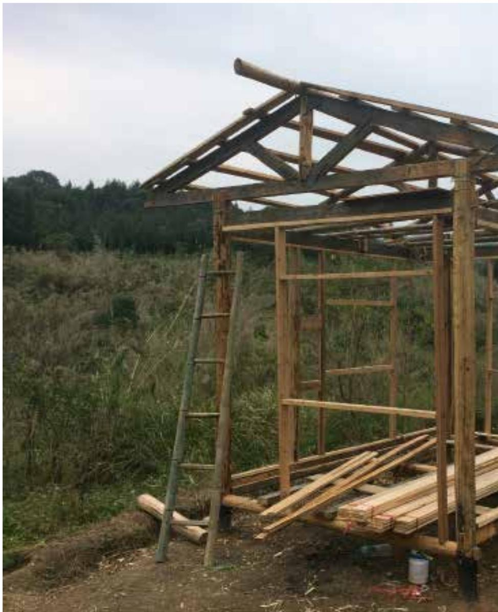
9. 将 3 个三角形屋顶木架放置，与主体结构连接起来，并用木条和钉子将三个木架连接
