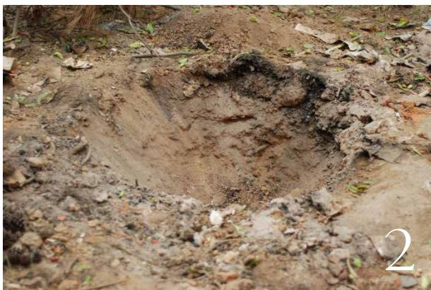
2. 挖掘一个直径 1.2 米以上，深度 50 厘米左右的土坑
