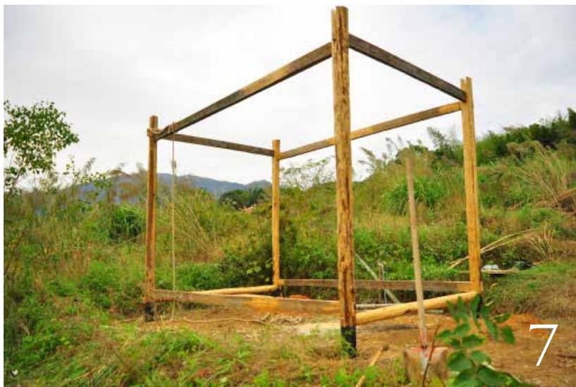
7. 将房主体结构组装并埋入坑中
