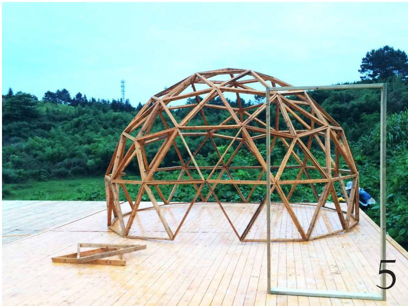
5. 将三角形采用螺栓或螺丝,按照左图进行组装( 每条边对应字母 )
