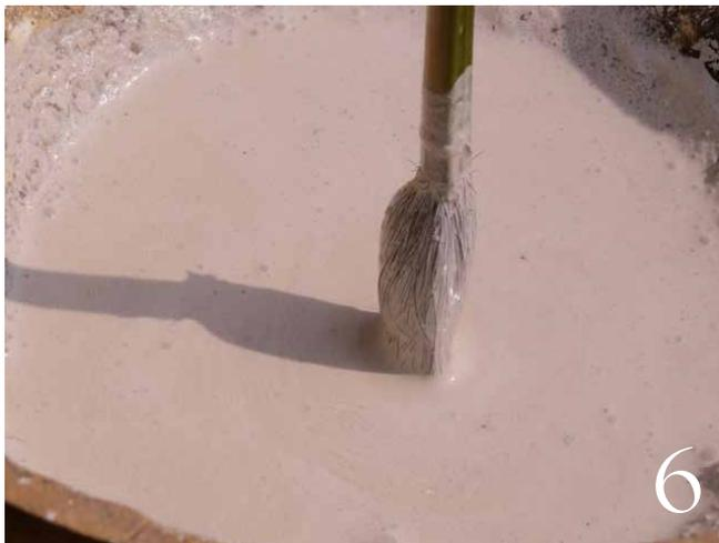
6. 静置 20 分钟以上。将毛刷沾匀浸透（毛刷可采用竹子或木头与动物毛发捆绑制成），或取底部膏状石灰，取一些用刮板涂抹，效果光滑
