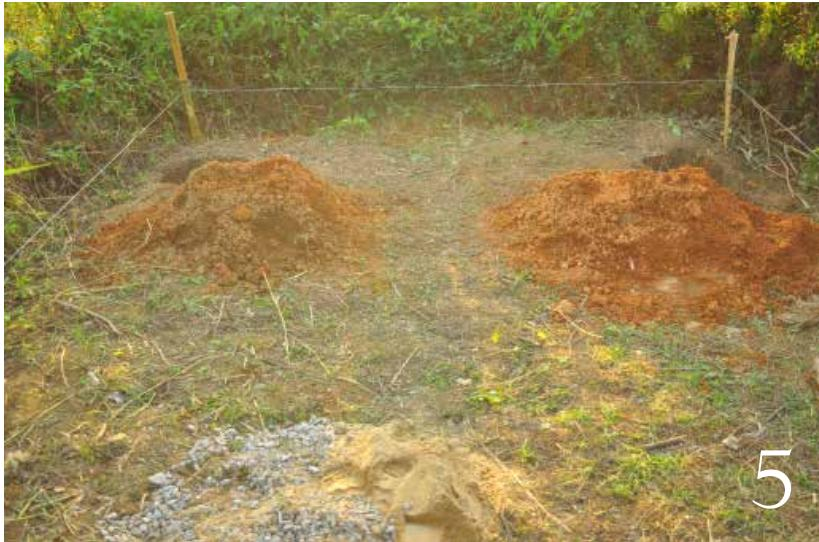
5. 挖好埋放立柱用的 4 个深度超过 40cm 的坑洞
