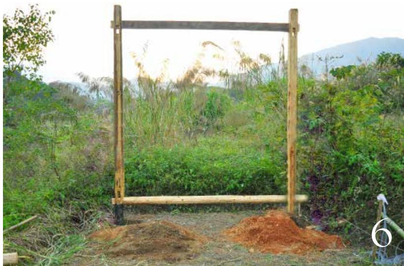
6. 将木结构插接并树立起来，插进坑洞中
